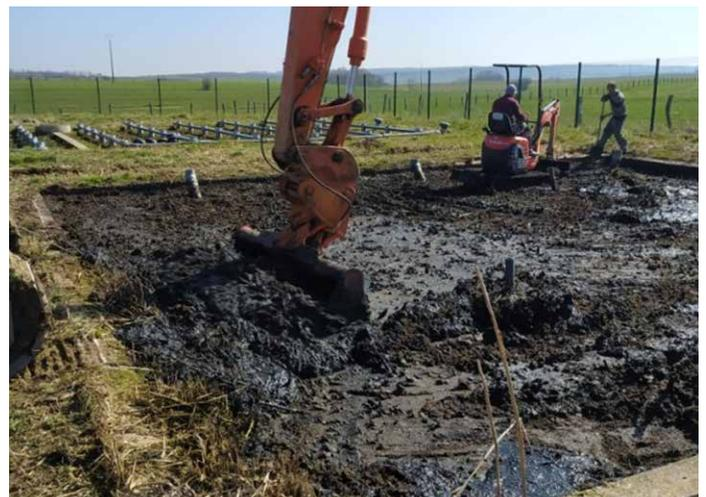
Après 13 ans de fonctionnement, la station de Puzieux avait besoin d'un nouveau souffle. En effet, année après année, les boues s'accumulent en surface de filtres, réduisant les capacités d'infiltration des eaux usées. La hauteur des boues atteignait jusqu'à 30 cm. L'opération de curage des boues a donc eu lieu les 24 et 25 mars. Les boues curées ont été analysées, stockées et envoyées sur la plateforme de compostage d'Anglemont.
